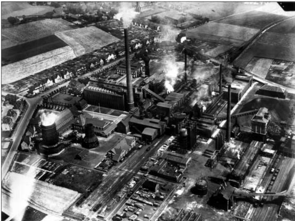
Ehem. Schachanlage Lothringen 4 (Quelle: Stadt Bochum)
